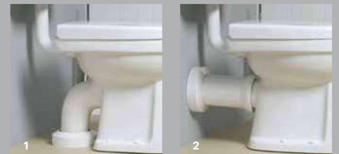
1 AO aansluiting 2 PK aansluiting
